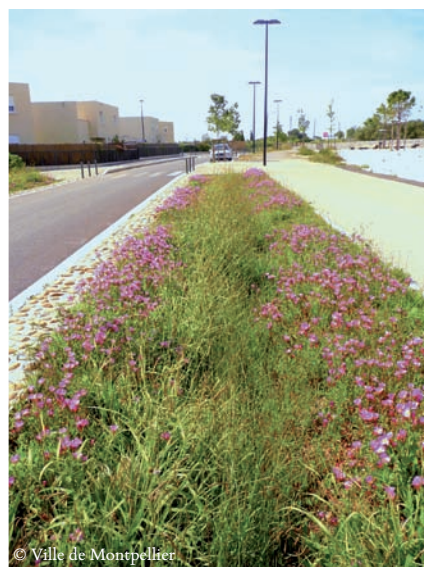
Noue végétalisée du quartier Malbosc au printemps.
